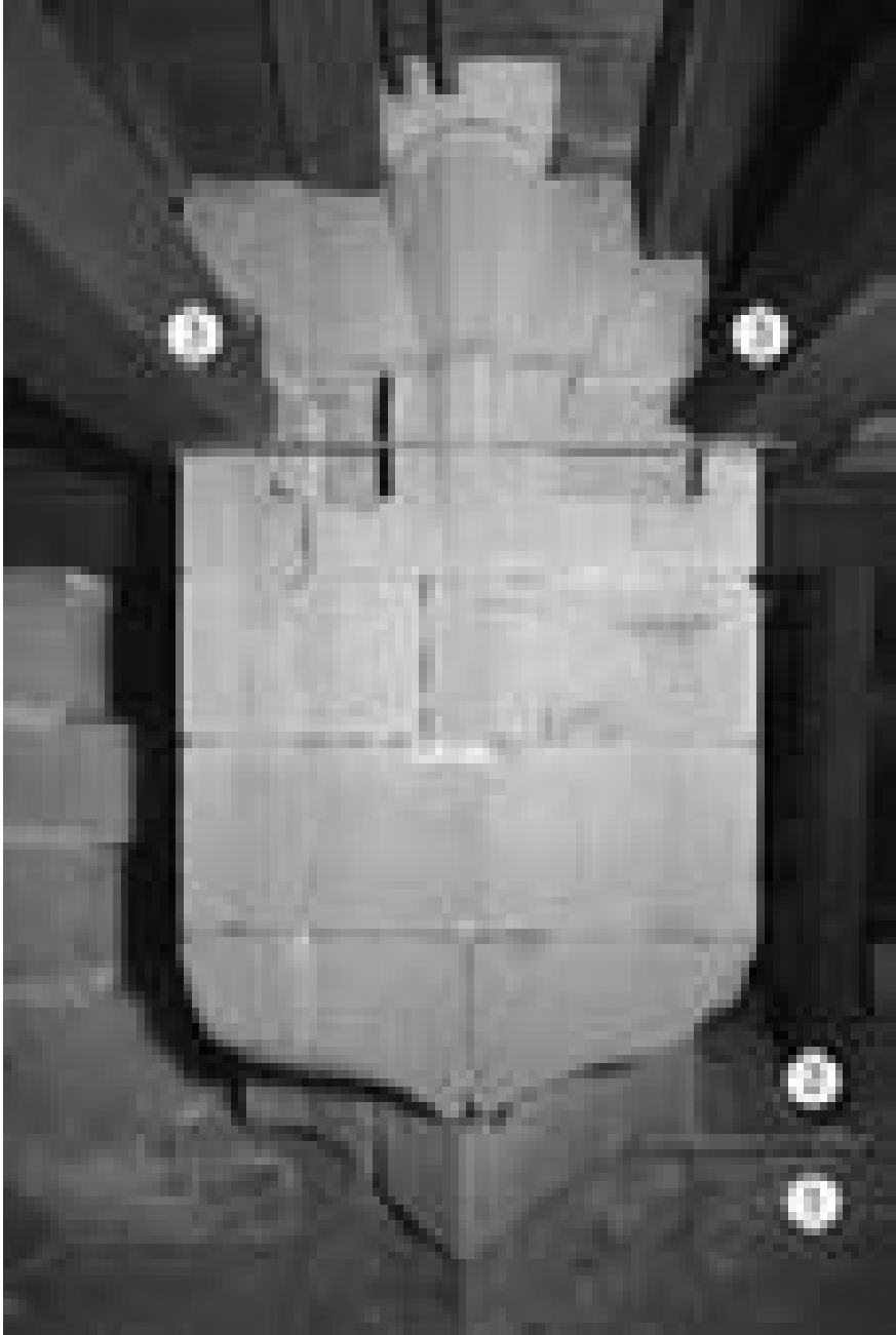
Abb. 8 Berner Münster, Strebepfeiler im Dachraum: 1 – Mauervorlage der 1440er-Jahre, 2 – Strebepfeileraufbau um 1500; 3 – gekürzte Dachbalken
