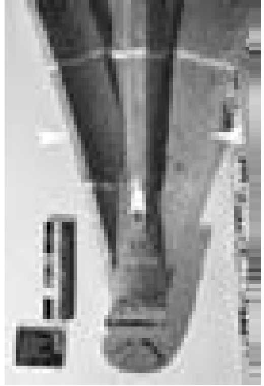
Abb. 6 Riedlingen, Spital zum Heiligen Geist (um 1500); Gewölbeanfänger aus gebranntem Ton mit deutlich erkennbaren Mittelrissen
