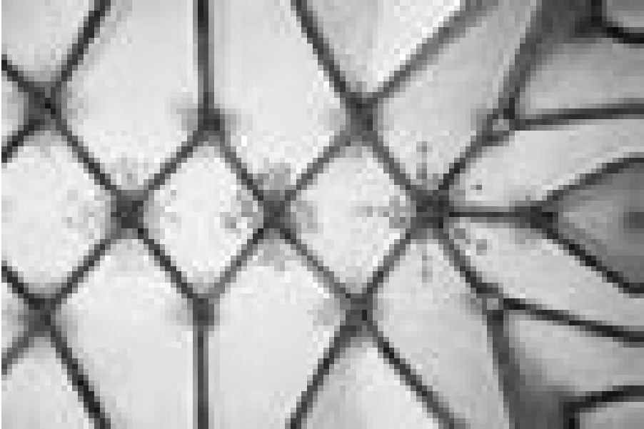
Abb. 2 Asch, Marienkirche (1492 [d], 1497 [i]); bei sämtlichen Bestandteilen des Netzgewölbes handelt es sich um materialsichtige Tonelemente
