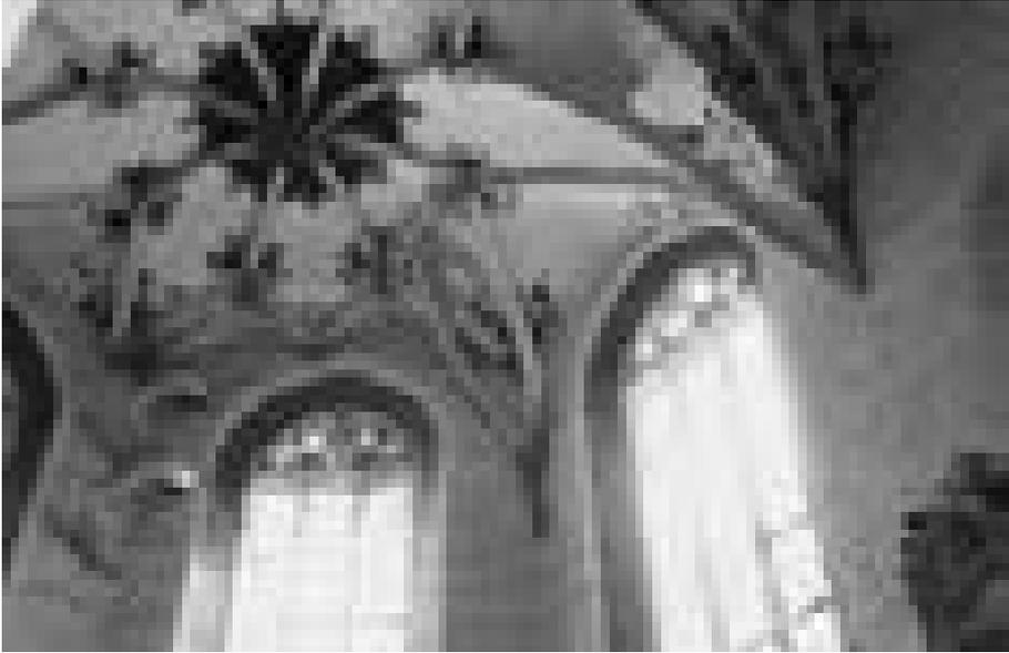
*Abb. 12 Pirna, Marienkirche, Gewölbe im Südchor; von Westen her lösen sich die Rippen mehr und mehr aus dem festen Gefüge einer materialgerechten Gewölbekonstruktion; die Rippe schwingt wieder in das Gewölbe ein, das zweite Schlingrippenpaar wurde als Luftrippen aufgeführt und berührt nur noch leicht die Konstruktion; die sogenannte Hobelspanrippe entwickelt sich frei und wurde mit einem Schlangenkopf zu einem dämonischen Wesen umgestaltet*
