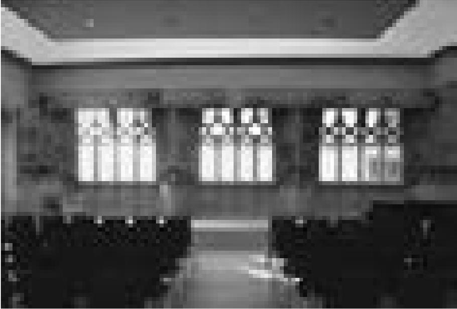
*Abb. 9 Erfurt, Collegium maius, Nordwand, Schauseite im Saal des Obergeschosses; vergleichsweise zierliche Spornpfähler rhythmisieren die Wand; ein durchlaufender Sturz spannt sich von einer Raumseite zur anderen, wobei unklar bleibt, wie die Tragfähigkeit der Konstruktion einstmal hergestellt wurde; zu berücksichtigen ist, dass auf dieser Steinwerkkonstruktion ein mächtiger, hoch aufragender Giebel auflastete*
