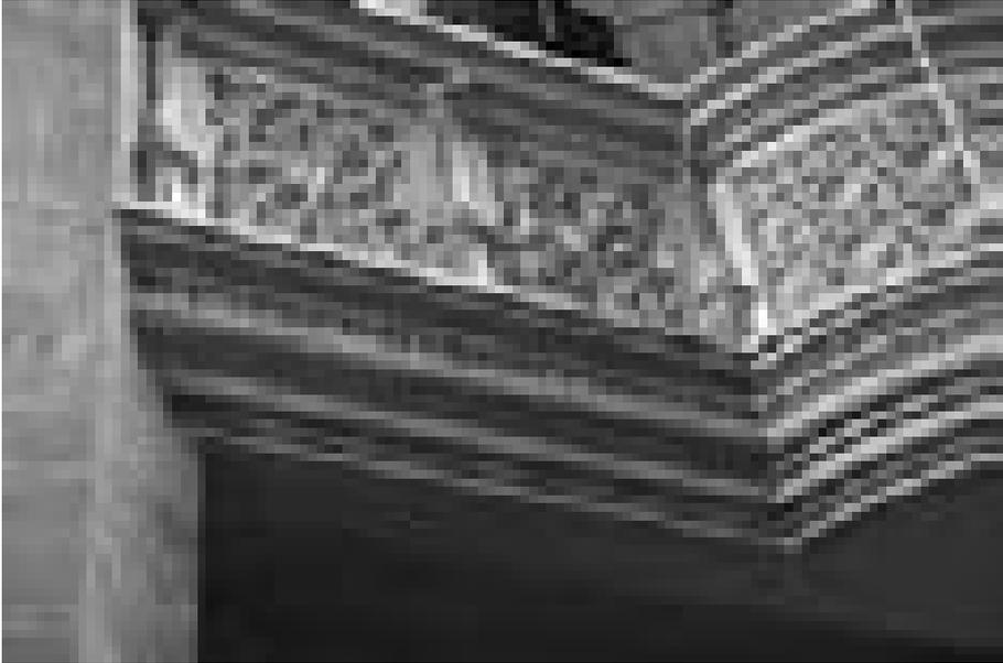
*Abb. 2 Halle (Saale), Marktkirche, südöstliche Empore; im Unterschied zu den anderen Emporenteilen wird dieser Abschnitt nicht von einem Bogen samt Gewölbe getragen, sondern besteht laut unterer Inschrift aus zwei Werkstücken; in welcher Weise die Tragfähigkeit der Konstruktion hergestellt wurde, ist äußerlich nicht ablesbar*
