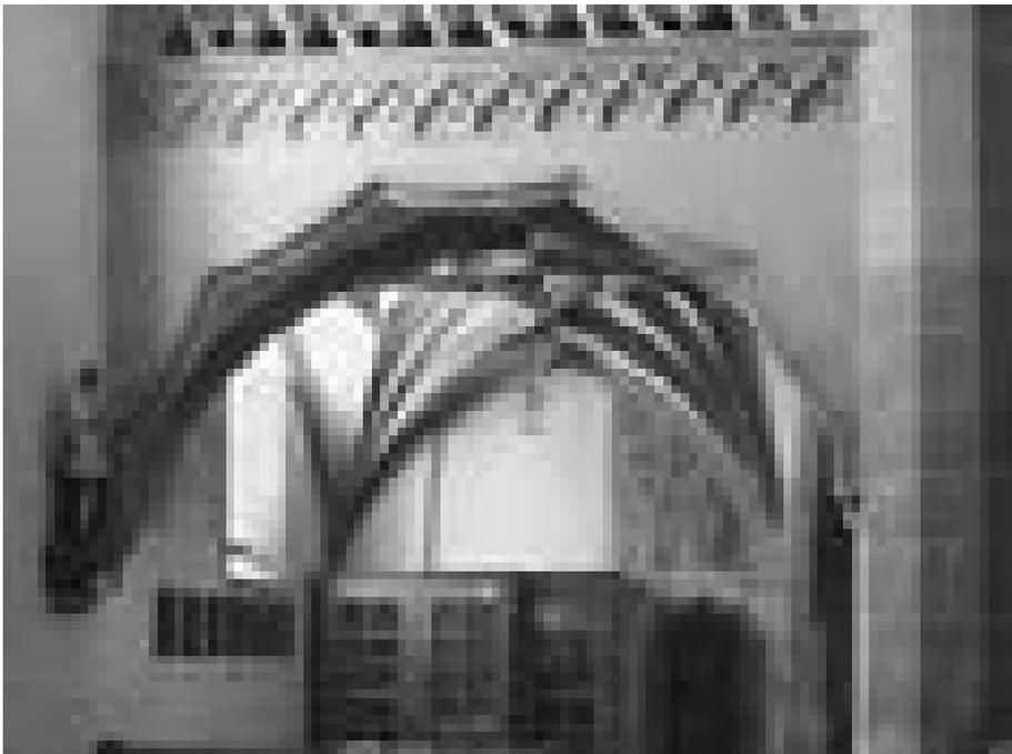
*Abb. 11 Bad Königshofen im Grabfeld, Maria Himmelfahrt, Scheidbogen der Westempore; konterkarierend zur materialgerechten Konstruktion wurde die Scheidwand sichtbar ausgedünnt, das Bogenprofil entsprechend stark ausgehöhlt und tief profiliert, zudem der Bogen und die Konsolen der Auflager hängend ausgeführt*
