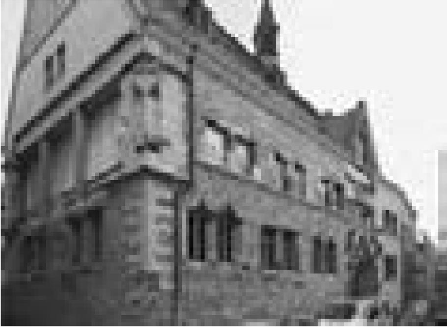
*Abb. 10 Erfurt, Collegium maius, Nordfassade während der Rekonstruktion; zu sehen ist, dass die Tragfähigkeit der Konstruktion des wiederhergestellten Werksteinmauerwerks heute durch einen mehrfach unterstützten Betonunterzug gewährleistet wird*
