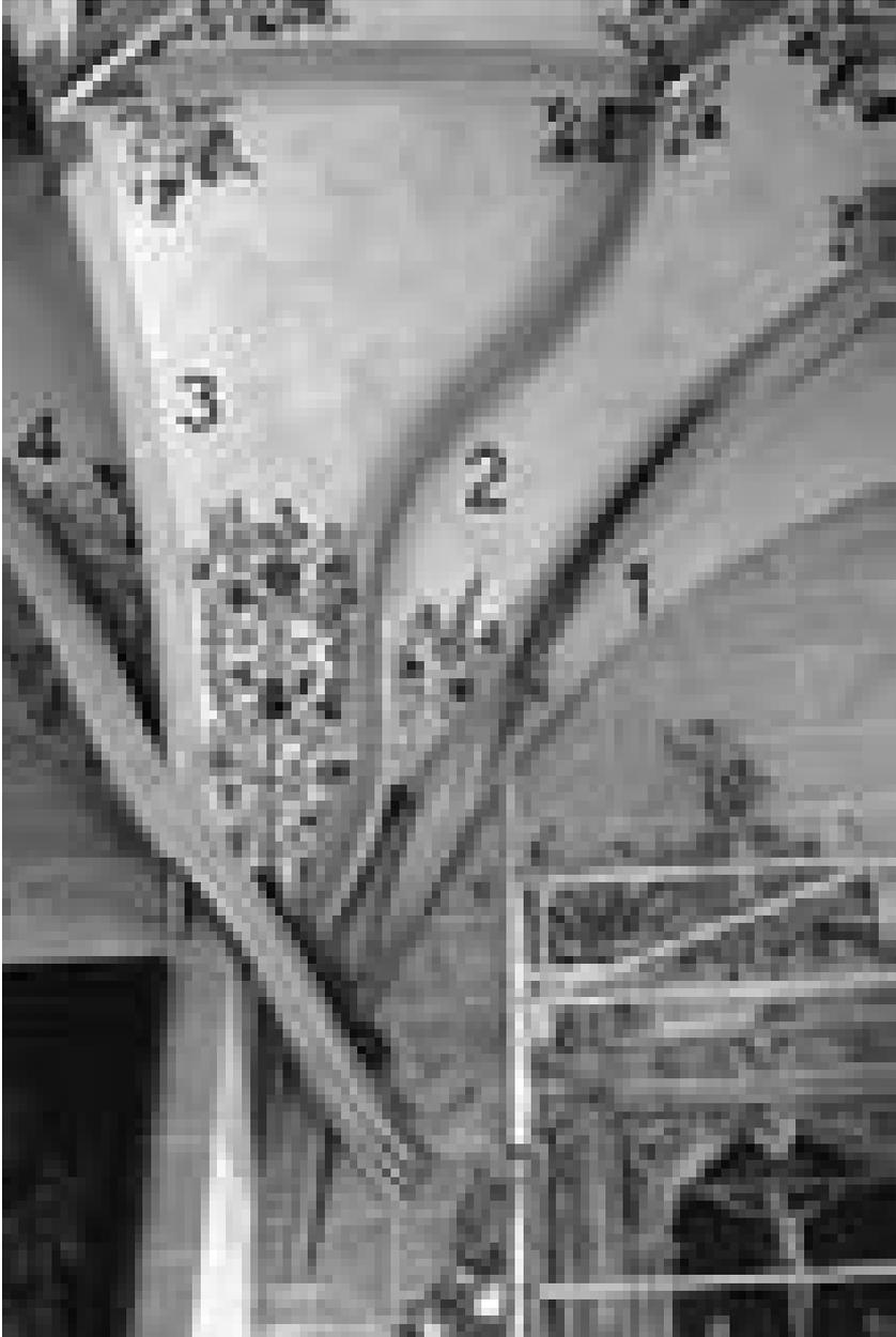
*Abb. 5 Pirna, Marienkirche, Westwand, Gewölbeanfänger in einem unregelmäßigen Wandanschluss mit musterhaft ausgebildeten Rillenverläufen gemäß abnehmender Form- und Bearbeitungsintensität: 1 tordiert, 2 gewunden, 3 scheinrecht; Rippe 4 als gewellte Linie und Weg des geflügelten Drachens*
