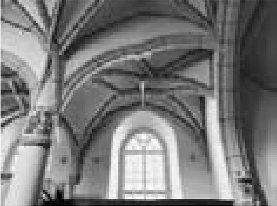
*Abb. 3 Dohna, Marienkirche, östliche Nordarkade, Scheidbogen mit diskontinuierlichem Verlauf; sowohl die Einbindung des Bogens in den Chorbogen als auch der Bruch des Bogens wird durch sogenannte ›durchschlüpfende Schenkel‹ samt gekappten Endungen sichtbar gemacht; unmittelbar hinter dem Bruch befindet sich im Rippenwinkel des Gewölbes eine auf einer Wolke schwebende Muttergottes mit Kind; den Fußpunkt der Konstruktion bildet die feste Wappentafel des Stifters Günter von Bünau*
