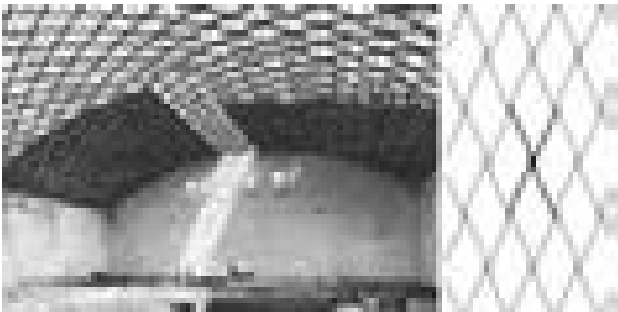
Abb. 7 Hünnebeck-Lamellendach der dritten Stufe; Aufbau einer Zuckerlagerhalle in Offstein, 1932
