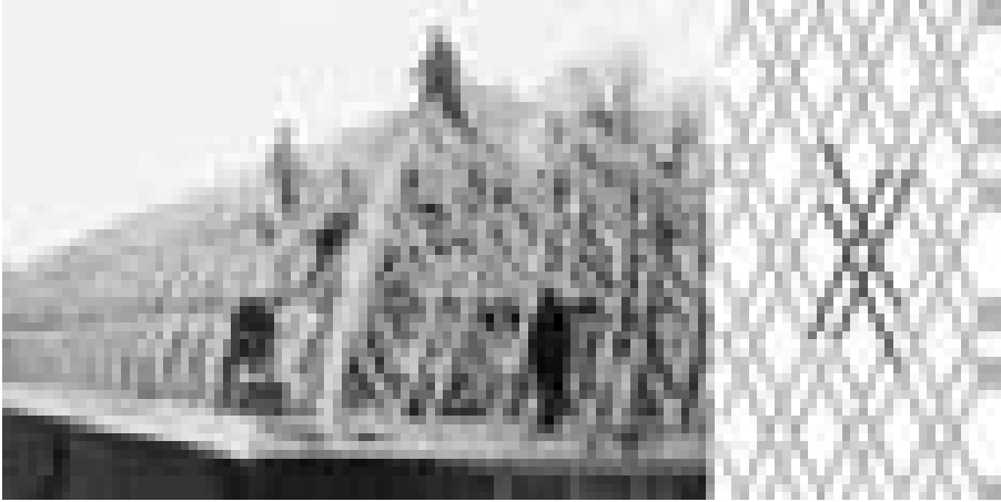
Abb. 3 Hünnebeck-Holzlamellendach der zweiten Stufe: Kornhalle der Firma Weiler-Heineberg-Flechtheim, Brakel 1927
