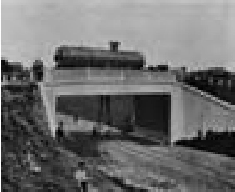
Abb. 6 Brücke über die Chemnitztalbahn bei Markersdorf/Sachsen, Belastungsprobe am 30. Mai 1901
