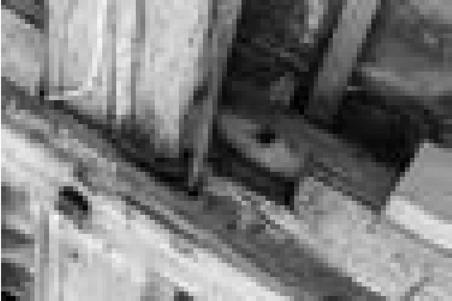
Abb. 7 Derneburg, gestoßene Mittelfette in der Zange des ›Laves-Sparrens‹ im Nordflügel
