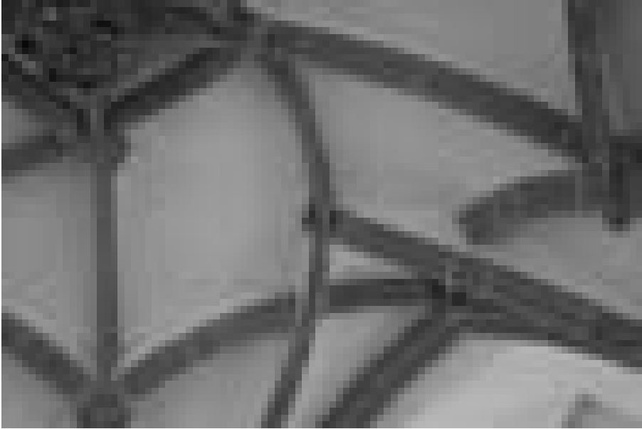
Abb. 1 Gewölbe mit räumlich gekrümmten Rippenbögen im Wappensaal der Albrechtsburg Meissen, Jakob Heilmann, 1521
