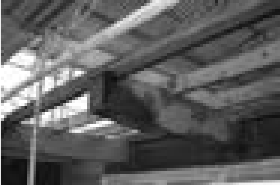
Abb. 6 Einsteinhaus Caputh, Kasein verleimter Hetzerträger
