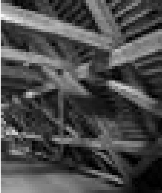
Abb. 2 Oberpfarrmurn bei Munchen. Dachwerk mit liegendem Stuhl ohne Spannriegel (1808)
