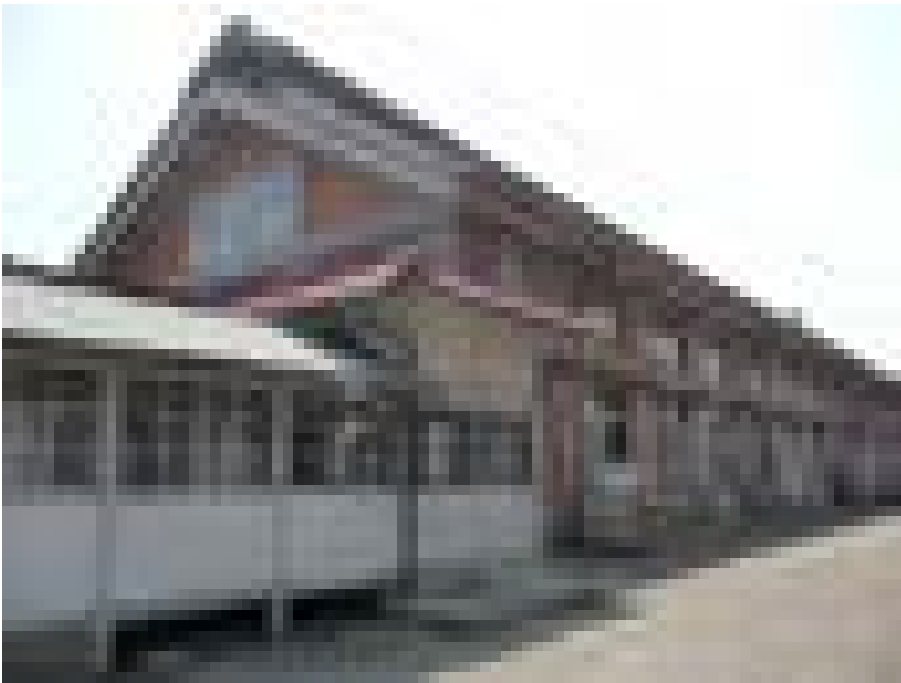
Abb. 2 Seidenhaspelhalle mit Dachaufbau »yagura«, Seidenspinnerei Tomioka
