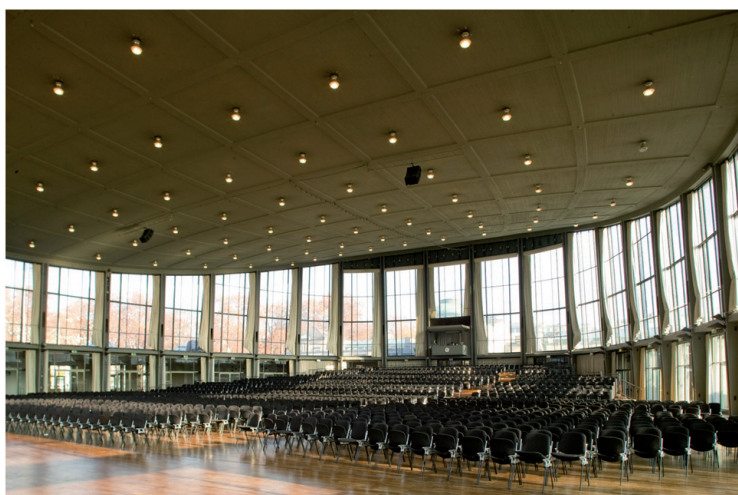
Bild 2: Deckenuntersicht mit schalungsrauer Kassettierung (Foto: LAD im RPS, Dienstsitz KA, Bernd Hausner)
