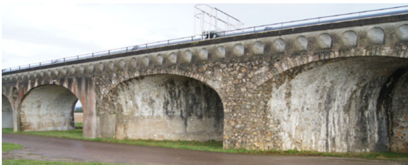
4 Vanne-Aquädukt bei Gisy-les-Nobles, 1872, schiefe Wegdurchführung in Bruchstein
