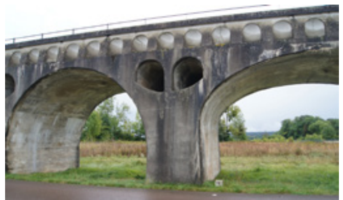
3 Vanne-Aquädukt bei Gisy-les-Nobles, 1872
