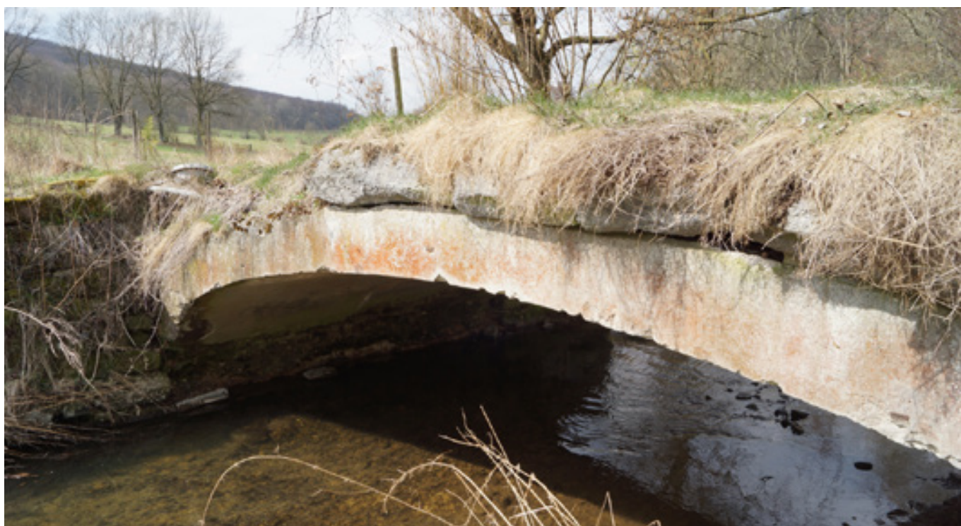
5 Brücke bei Vorwohle, 1877
