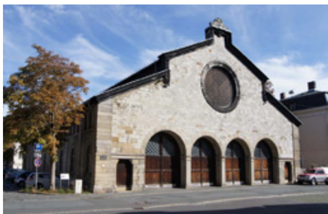
1 Einsteighalle in Hof, Außenansicht von Nordwest, 2012
