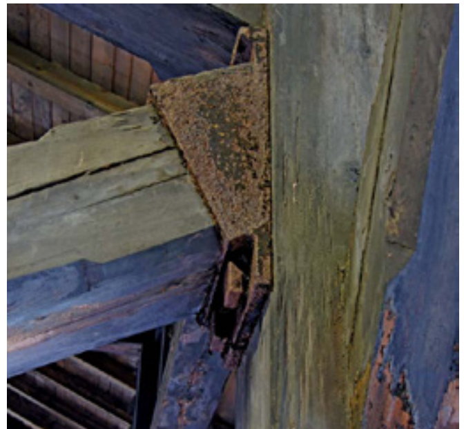
4 Einsteighalle in Hof, Balkenschuh zwischen Strebe und Hängesäule, 2012
