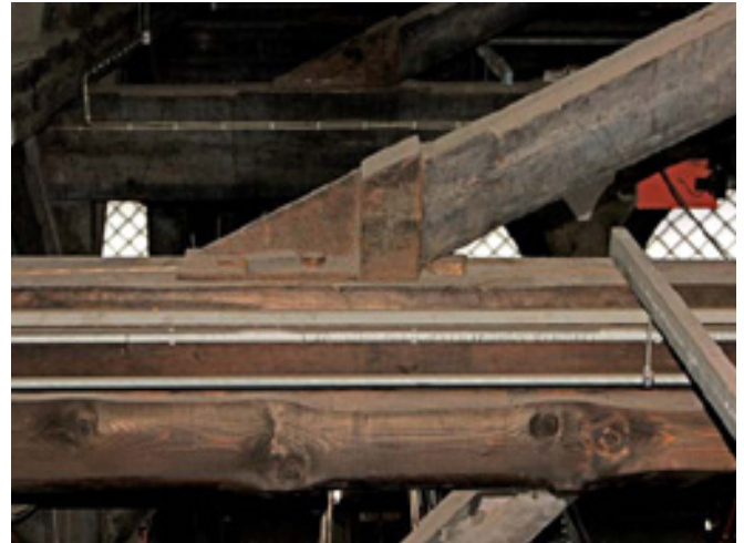
3 Einsteighalle in Hof, Balkenschuh zwischen Strebe und Zerrbalken, 2012
