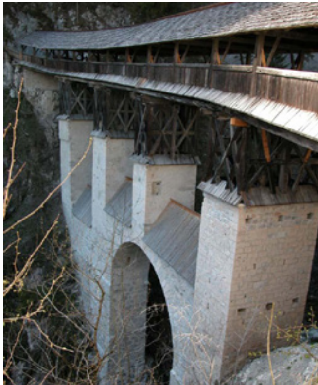
1 Gesamtansicht der Hohen Brücke St. Georgenberg von Südwesten nach Abschluss der Restaurierungsarbeiten
