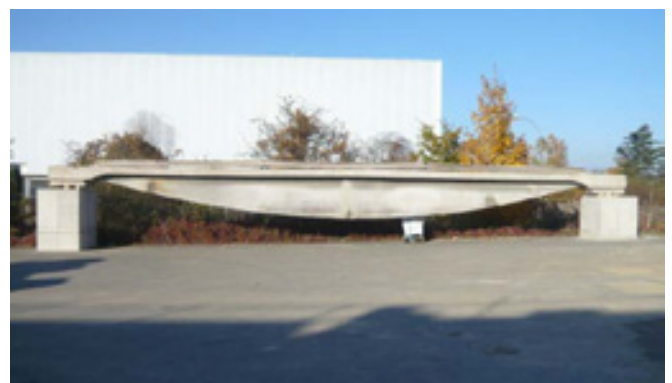
17 Abbruch und Bergung eines Trägers der Fallersleber-Tor-Brücke, 2009
