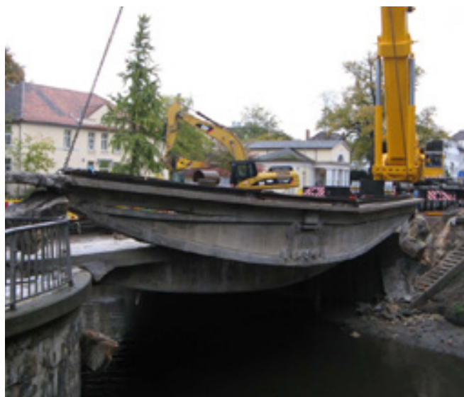
1 Fallersleber-Tor-Brücke, Braunschweig, Abbruch 2009 (Foto: Rosner)
