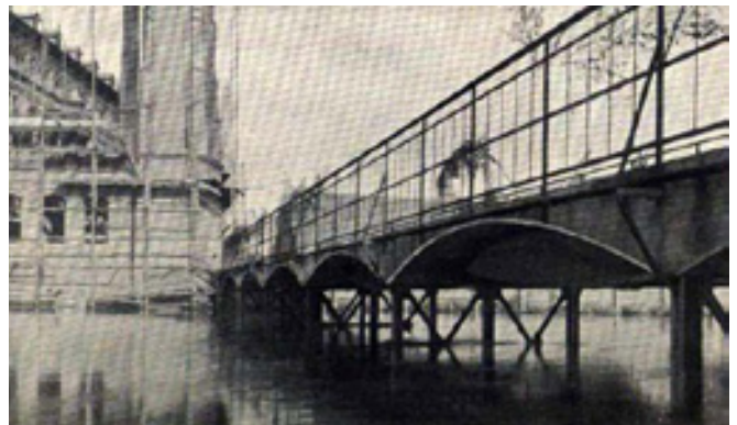
10 Eisenbahnbrücke bei Rünigen, 1894 [Firmenschrift 1904 / Möller 1897, Bl. 17]
