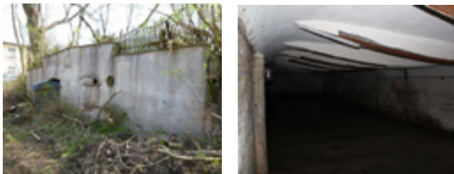
6/7 Kellerdecke der Firma Brachvogel, Baujahr 1899, Zustand 2013
