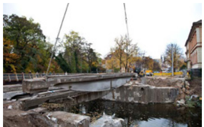
16 Abbruch und Bergung eines Trägers der Fallersleber-Tor-Brücke, 2009
