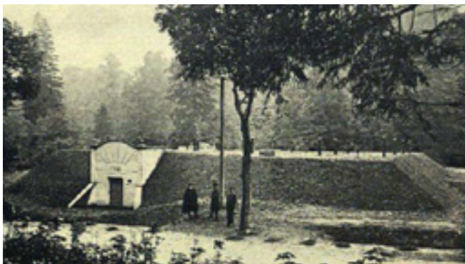
8 Hochbehälter, Bad Harburg [Firmenschrift 1907]
