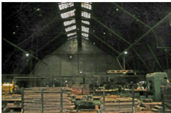
3 Wiedererrichtung der Luftschiffhalle als Sägehalle
