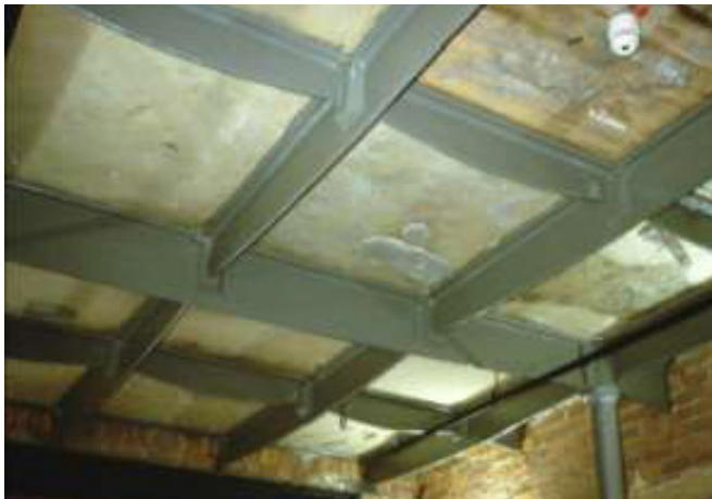
17 Beehive Mill, Manchester, 1824, typische gusseiserne primäre, sekundäre und tertiäre Fischbauchbalken mit T-Querschnitt
