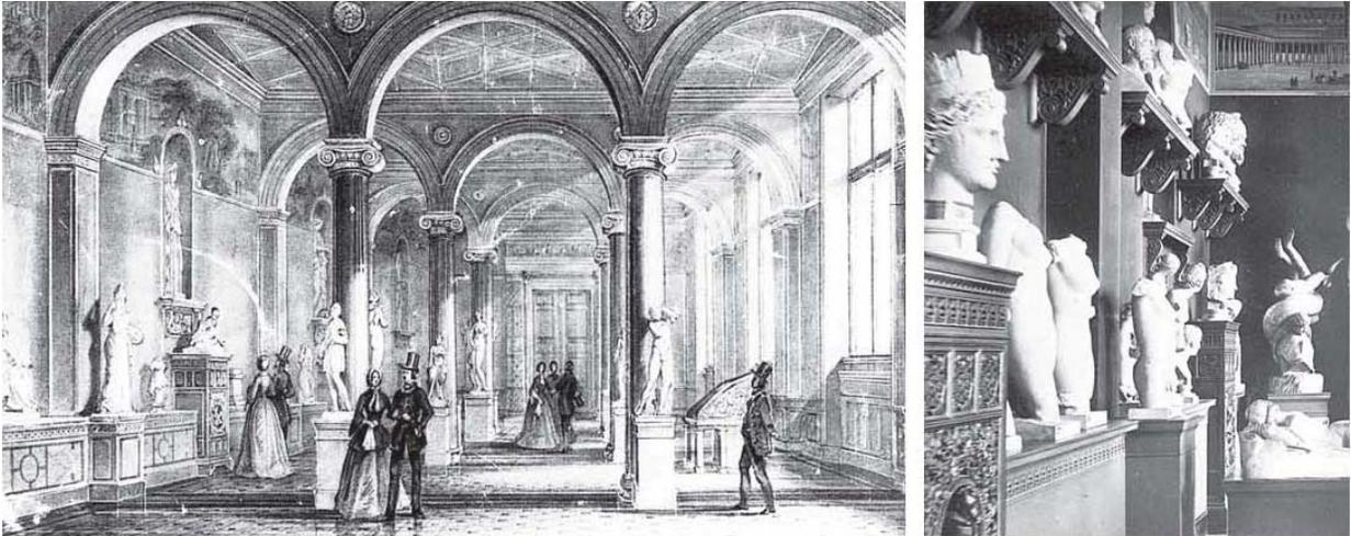
Figure 5: Neues Museum, Roman Room, View of the bricked panels and the hot water oven mantles, concealing the flues of the water heating, Fig. left: approx. 1860; Fig. right approx. 1920 (Bundesamt für Bauwesen und Raumordnung Berlin)
