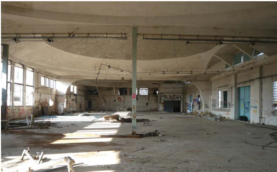
Karlsruher Flugzeughalle 4, Innenansicht der offenen Hallenabschnitte mit drei Kuppelschalen (Foto Christina Czymay 03.2014)
